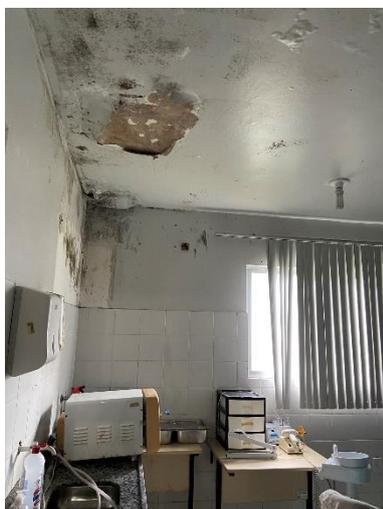
Figura 11: Remover infiltração e executar pintura.
